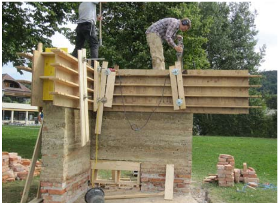
Studenten beim Bau einer Stampflehmwand, internationaler Workshop EarthWorks 2010
